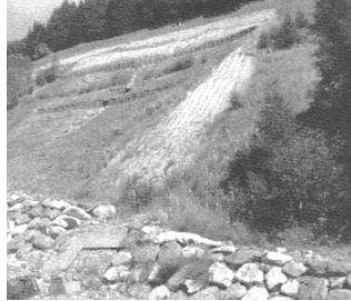
Monno: Pietre e legno utilizzati in Val Dorena per fermare i movimenti franosi.
