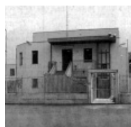
La nuova caserma della Polizia stradale a Darfo B.T.
