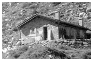
La malga Salarno in comune di Saviore durante i lavori di riqualificazione.
