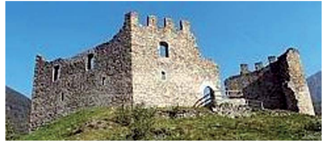
Cimbergo: I resti dell'antico castello dopo i restauri
