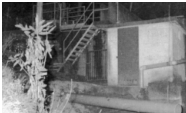
Il depuratore di Piazze sommerso dalla frana.
