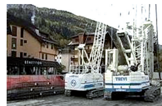
I grossi macchinari impiegati per lo scavo sotto piazzale Europa.
