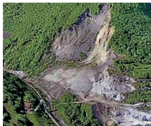
L'area del Trobiolo dopo gli interventi di messa in sicurezza.
