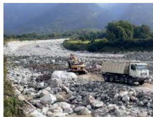
Sonico: Lavori nell'alveo dell'Oglio.
