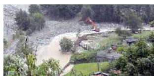
Sonico: Interventi di sistemazione del torrente in Val Rabbia.
