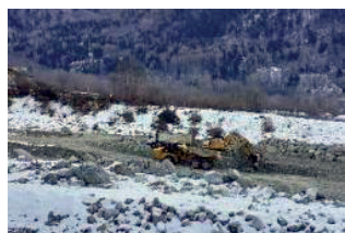
Lavori in corso per spostare i detriti della Val Rabbia.
