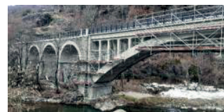
Capodiponte: Il ponte dopo le opere di riqualificazione.
