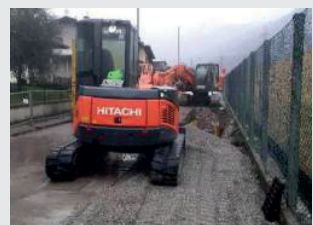
Malonno: Iniziati i lavori del collettore fognario.
