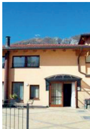
Lozio: L'ingresso della RSA.
