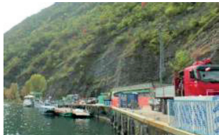
Montisola: il versante interessato ai lavori.
