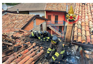
Vigili del fuoco sul tetto.
