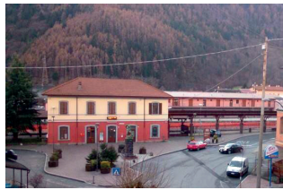
La stazione di Edolo dove verrà realizzata la centrale a idrogeno.
