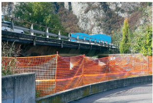
I lavori sul ponte.
