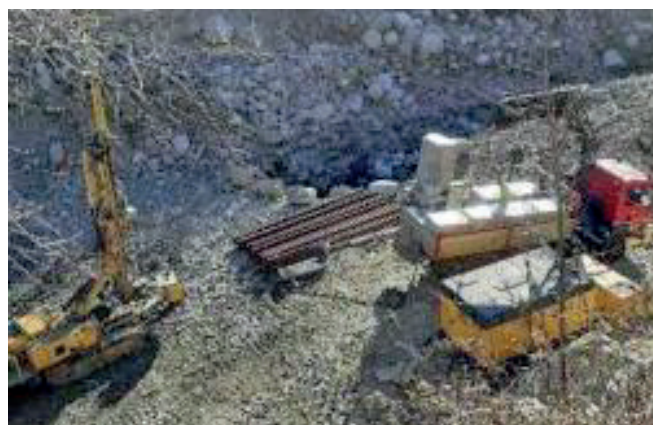
Sonico: Lavori in corso per mettere in sicurezza l'abitato di Rino.
