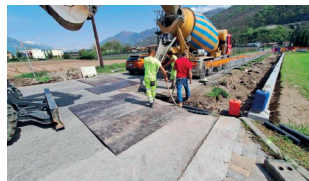
Pisogne: Lavori in corso per completare la ciclabile.
