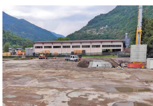
Edolo: L'area predisposta per l'impianto di produzione dell'idrogeno.
