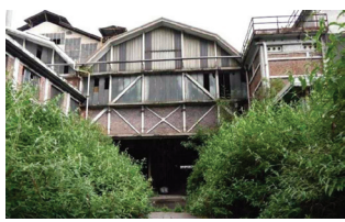
Forno Allione I capannoni della ex Selca.
