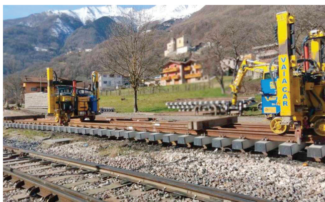
La posa di nuovo materiale rotabile.
