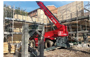
Darfo B.T.: Cantiere aperto per il Centro per l'impiego.
