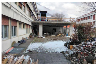
Edolo La mensa in costruzione.
