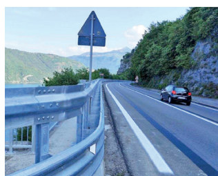
Marone: Un tratto della 510 dopo i lavori di messa in sicurezza.
