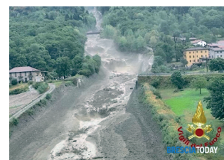
Il ponte crollato a Rino di Sonico.
