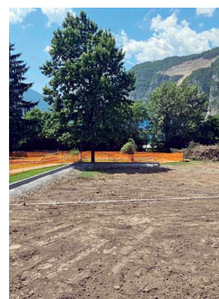
Civate: L'area camper in allestimento.
