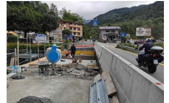
Monno: Lavori in corso sul ponte.
